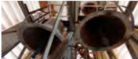
Blick in die Glockenstube nach Reparatur und Turmsanierung © M. Hergt
