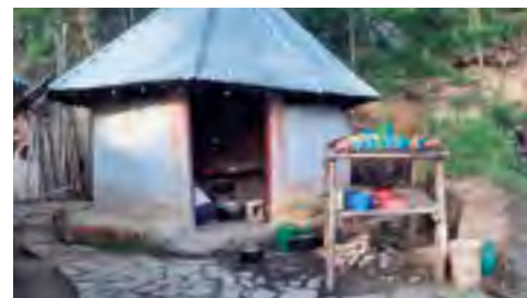
Küche auf der Baustelle am Lake Bunyonyi
